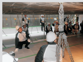
東京都・首都高速道路工事現場
