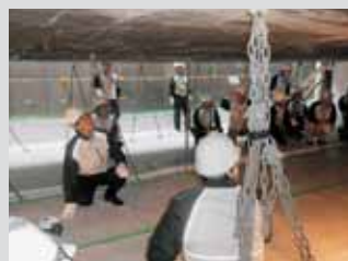
東京都・首都高速道路工事現場
